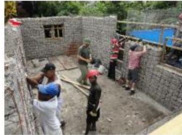
(d) Adjusting window and door openings
