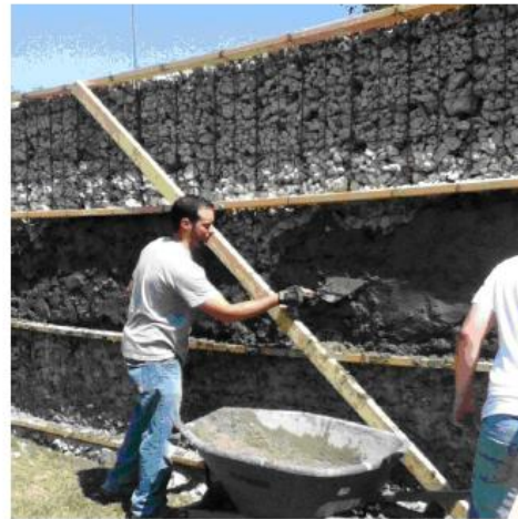
(d) Applying cement finish
