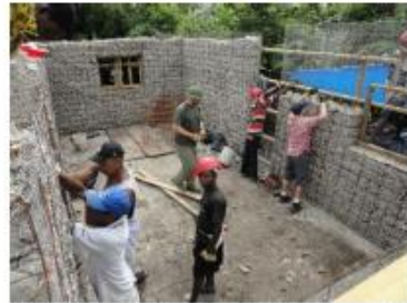
(d) Adjusting window and door openings
