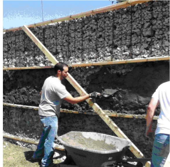
(d) Applying cement finish
