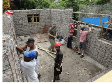
(d) Adjusting window and door openings
